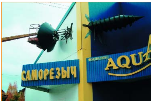
Элемент наружной рекламы для фасада, «Саморез», изготовлен из металлоконструкции, обшитой ПВХ-листами UNEXT-Classic 3 мм, UNEXT-Classic 5 мм и UNEXT-Classic 10 мм, обклеенных черной матовой пленкой. Изготовитель: ИП Чупрова С.А. (Ухта).
